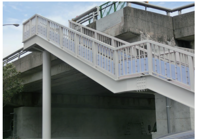
鋼製階段、歩道橋
